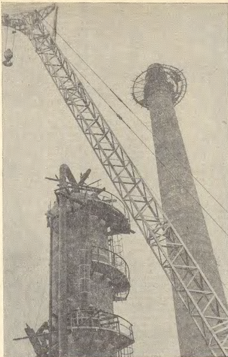
На строительной площадке газзаводов
